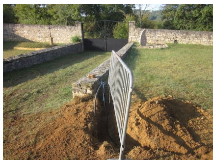
Travaux d'alimentation en eau au cimetière
